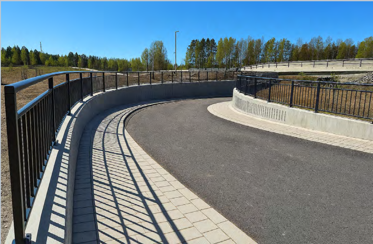
Jalankulku- ja pyöräilyväylän kaukalorakenne Mt130 ali Keskokadulle Kuva: Nurmijärven kunta
