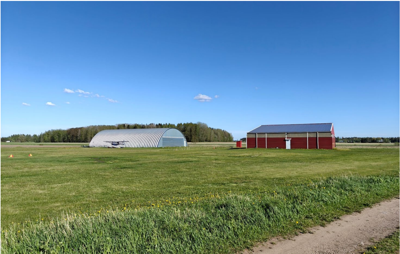
Kuva 6: Savikon lentokentän hallirakennukset erottuvat peltoaukealla maamerkkeinä sijaintinsa sekä muotonsa vuoksi.
