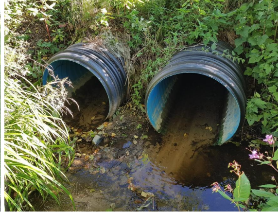
Kuvat 10. ja 11. Ylikorventien alittavat 800 mm muovirummut, oikeanpuoleinen kuva purkupäästä. [Ramboll 9/2021]
