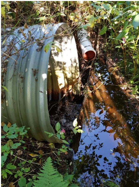
Kuva 14. Risusillantien alittava 1200 mm teräsrumpu, kuva rummun yläjuoksulta. [Ramboll 9/2021]
