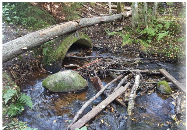
Kuvat 15. ja 16. Kassakumuntien alittava 1600 mm betonirumpuputki, oikeanpuoleinen kuva purkusuulta. [Ramboll 9/2021]
