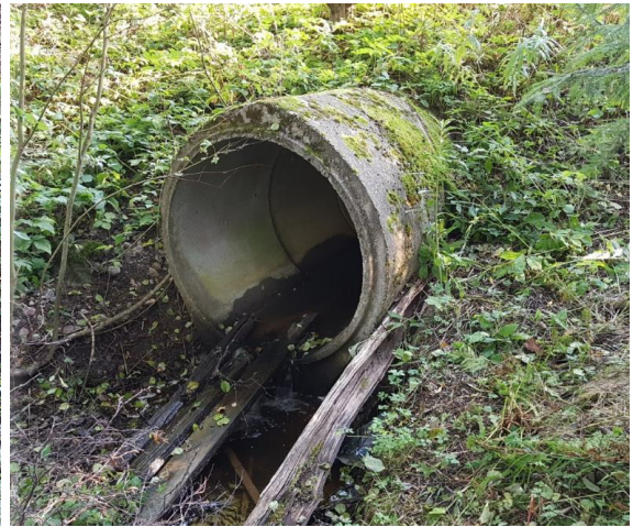
Kuvat 12. ja 13. Lopentien (Mt 132) alittava 1200 mm betonirumpu, oikeanpuoleinen kuva purkupäästä. [Ramboll 9/2021]
