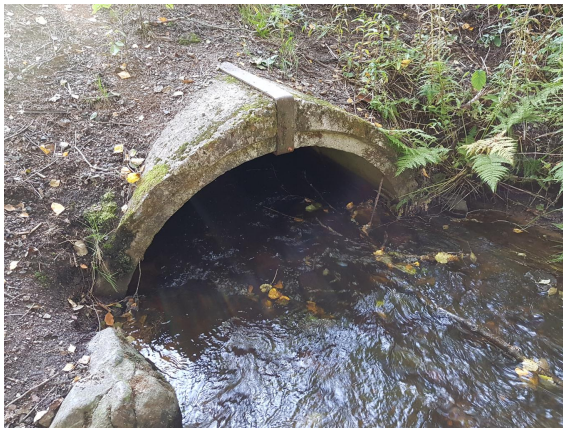
Kuvat 15. ja 16. Kassakumuntien alittava 1600 mm betonirumpuputki, oikeanpuoleinen kuva purkusuulta. [Ramboll 9/2021]
