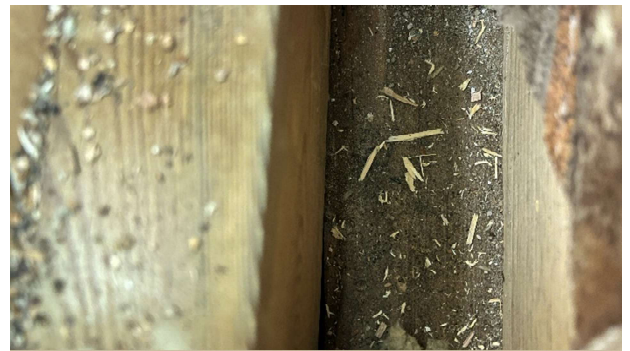
Kuva 173. Eristetilassa tummentumaa.
