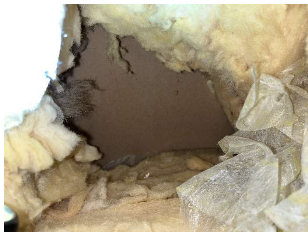
Kuva 132. Rakenneavaus US1. Ikkunan alapuolisessa rakenteessa on tuulensuojalevy ja tuulensuojalevyn takana lautaverhous.
