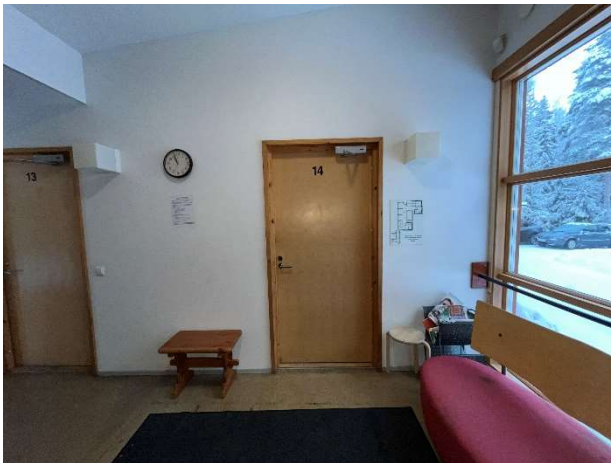
Kuva 13. Merkittävimmät väliseinärakenteet ovat huoneiden ja käytävän väliset väliseinät.
