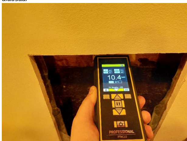
Kuva 135. Rakenneavaus US2. Poikkeavia puunkosteusarvoja ei havaittu.
