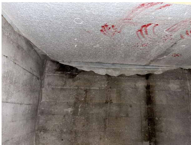
Kuva 100. Varastotilan laipiossa on EPS-eristeet.
