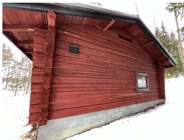
Kuva 165. Saunan ja pesuhuoneen alueen ulkoseinää.
