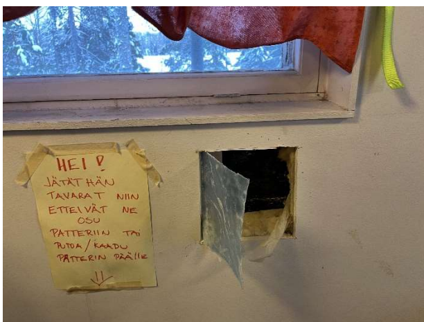
Kuva 86. Rakenneavaus US10, tila 210.
