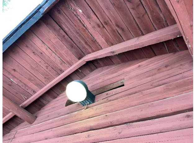
Kuva 177. Yläpohjan tuuletusaukot ovat saunan päädyissä.
