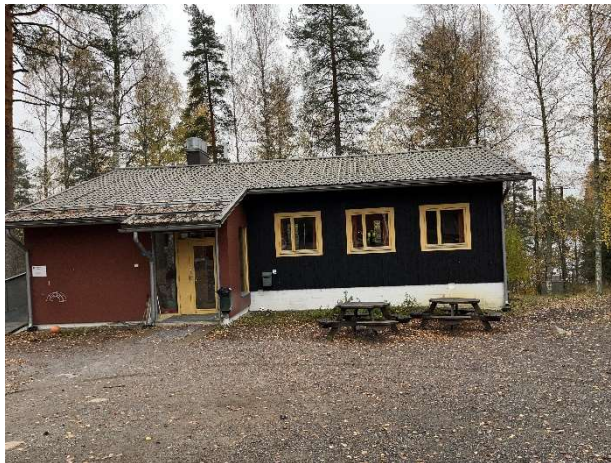
Kuva 101. Päärakennuksessa on peltikate.
