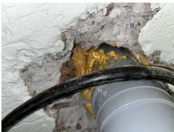
Kuva 109. Tekniikkäläpivienttiä.
