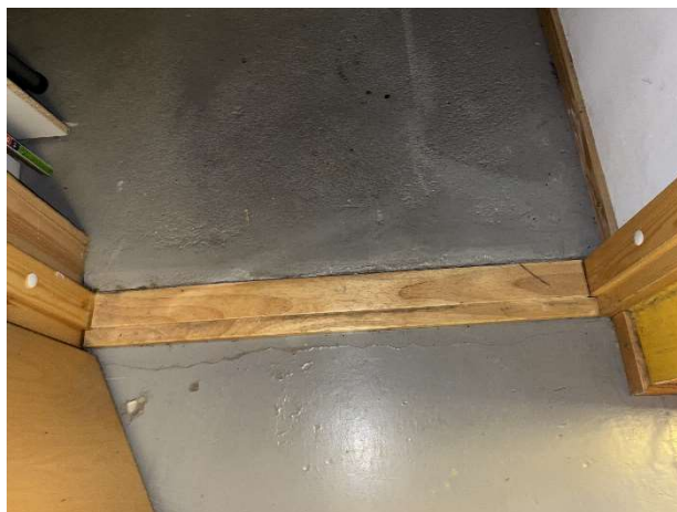
Kuva 58. Käytävälle on valettu n. 20 mm paksumpi pintalaatta.
