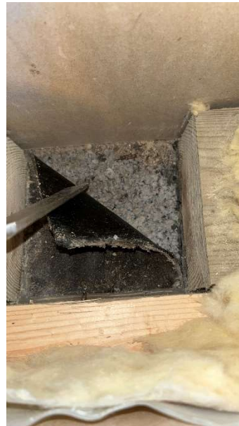
Kuva 26. Bitumikermi todettiin olevan paikoillaan kauttaaltaan.
