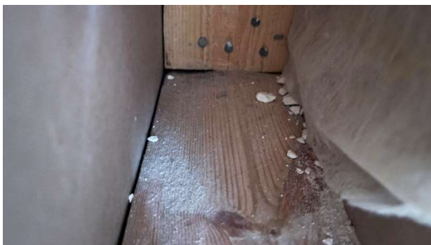
Kuva 15. Väliseinän sisällä ei havaittu kosteusrasitusta tai viitteitä vaurioitumisesta.
