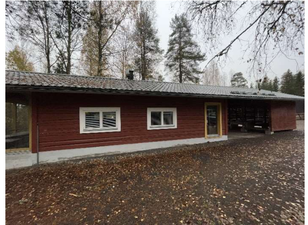
Kuva 112. Piha-aluetta ja rakennuksen vierustaa.
