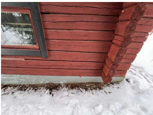
Kuva 162. Saunan alueen ulkoseinää.
