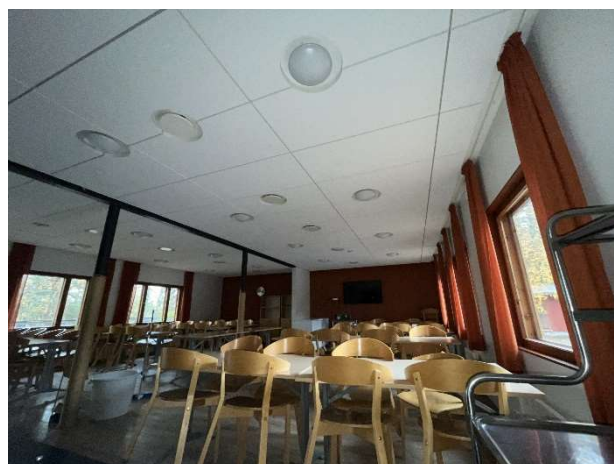
Kuva 110. 1. kerroksen ruokalutilan alaslaskettua kattoa.
