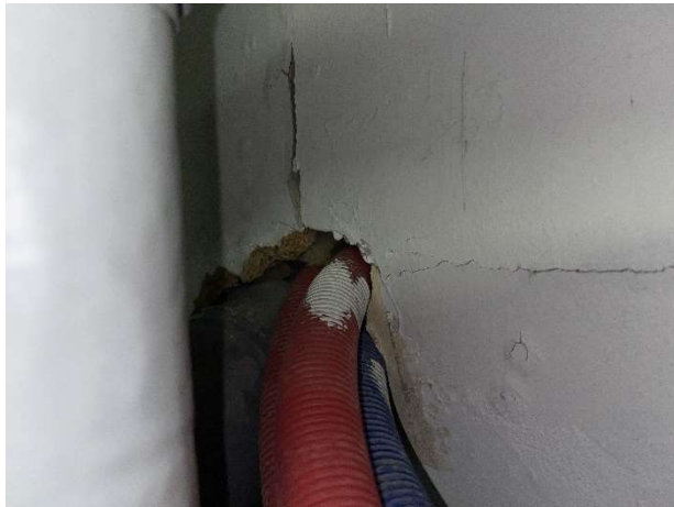
Kuva 107. Tekniikkäläpivientejä.
