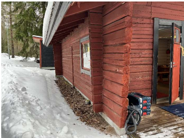
Kuva 160. Pohjoisen puoleista ulkoseinää.
