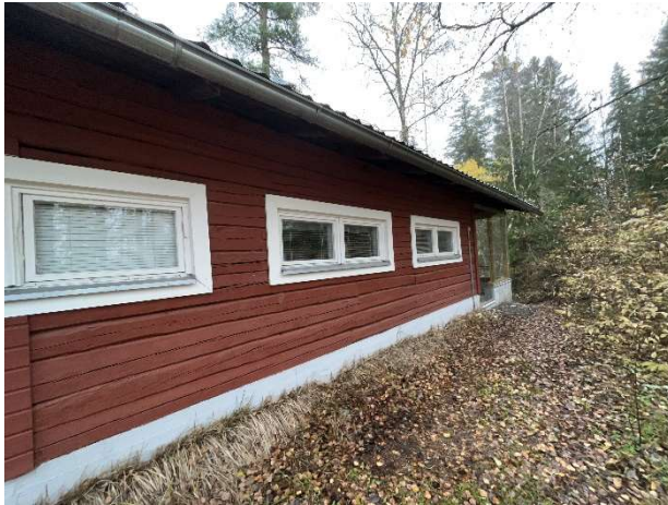
Kuva 115. Järven puoleista rakennuksen vierustaa.
