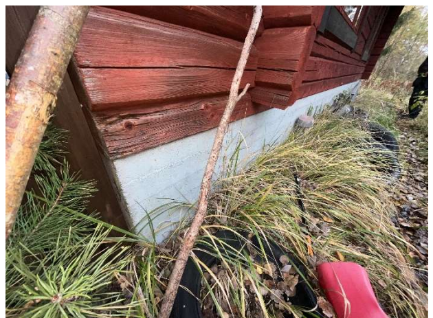
Kuva 153. Järven puoleista rakennuksen vierustaa.
