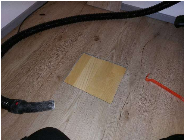
Kuva 117. Alapohjan rakenneavausta AP1.
