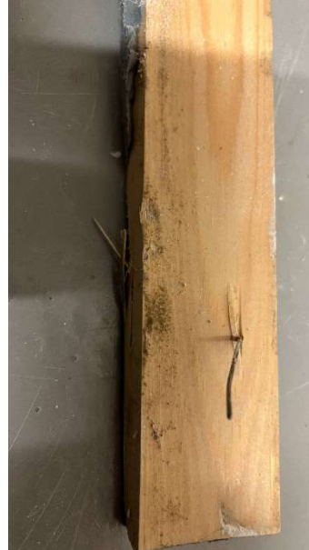
Kuva 83. Jalkalistan pinnalla kasvaa mikrobikasvua.
