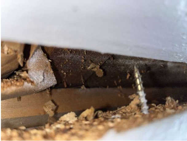
Kuva 176. Rakenneavaus YP1. Laipion pahvissa havaittiin selvää mikrobikasvua.
