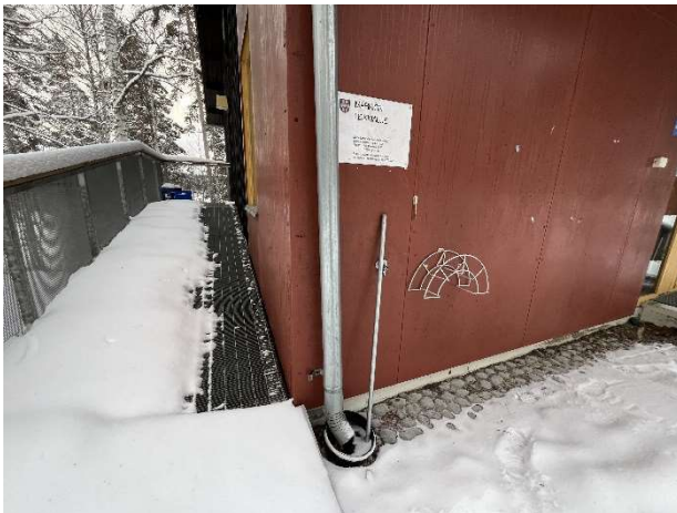
Kuva 53. Pohjoispuolen ulkoseinän vierusta on osittain kivetty luonnonkivillä.
