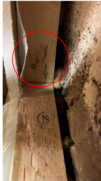
Kuva 81. Koolauksissa mikrobikasvuun viittaavaa tummumista.
