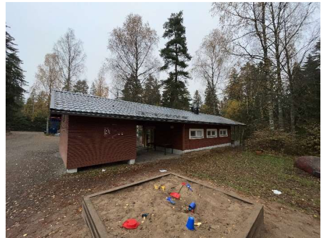
Kuva 114. Järven puoleista rakennuksen vierustaa.
