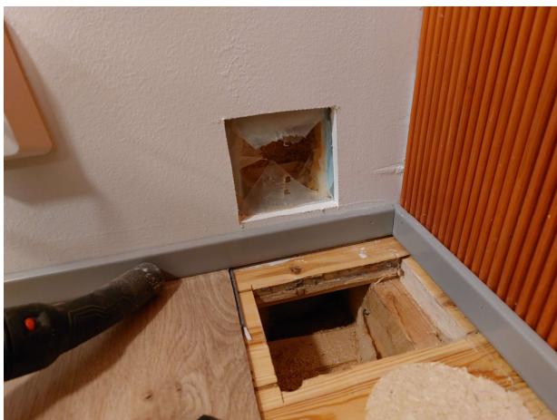
Kuva 89. Rakenneavaus US4, ruokasali.
