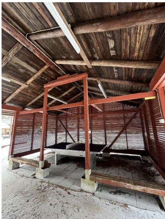
Kuva 141. Katoksen alueen vesikattoa.
