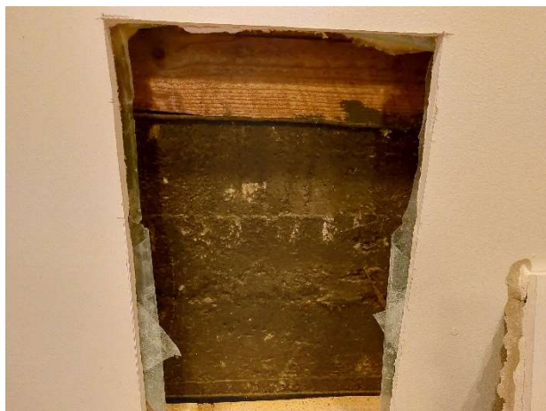
Kuva 133. Rakenneavaus US2 tehtiin ulkoseinän alaosaan. Kuvassa näkyy sokkelia ja ulkoseinähirren alaosaa.
