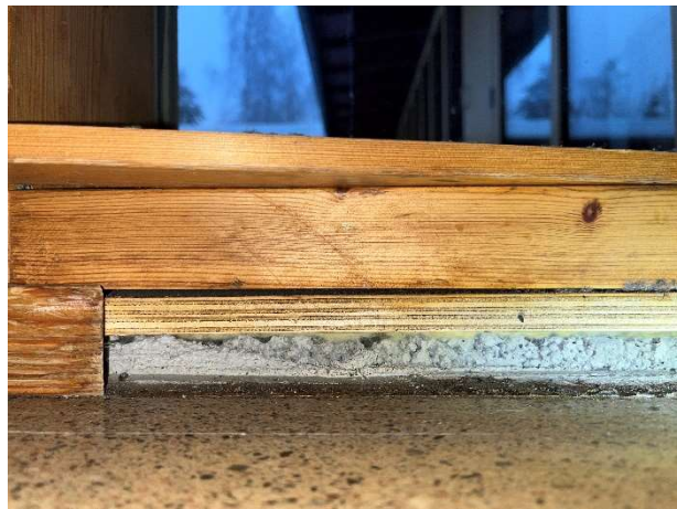
Kuva 28. Mineraalivillaa betonin ja puurakenteiden välissä.
