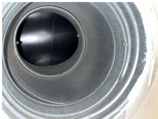
Kuva 46. Poistoilmakanavissa oli vähäistä pölykertymää.
