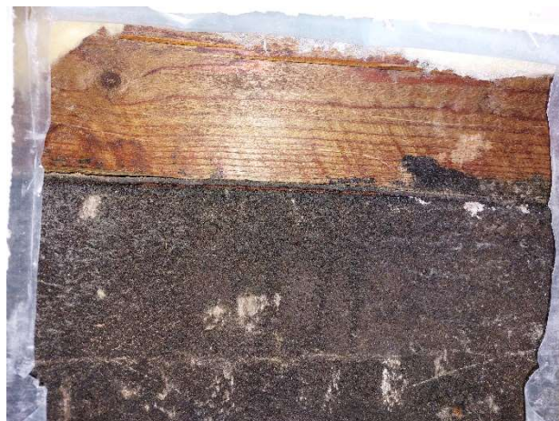
Kuva 134. Rakenneavaus US2. Kuvassa näkyy sokkelia ja ulkoseinähirren alaosaa.
