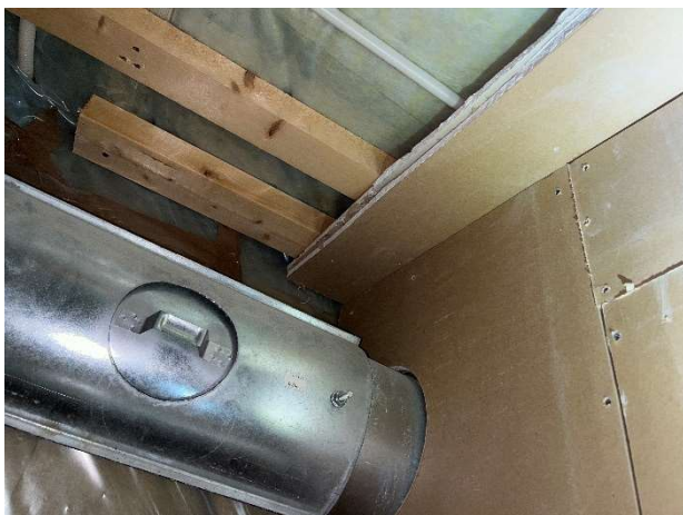
Kuva 43. Laskettujen kattojen päällä ei havaittu merkittäviä mineraalikululähteitä.
