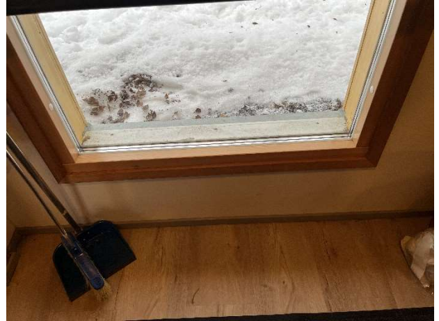
Kuva 122. Osa ikkunoista on kiinteitä ikkunoita.
