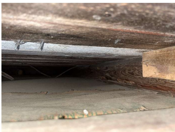
Kuva 143. Parkkipaikan puoleisella sivulla yläpohja tuulettuu räystäältä.
