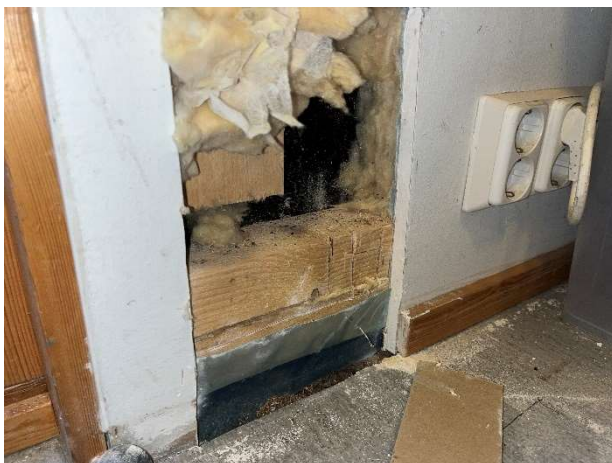
Kuva 84. Rakenneavaus US2 toimistohuoneen ulkoseinä
