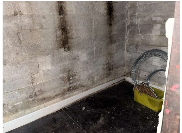
Kuva 99. Varastotilan betoniseinään porattiin reikä, jolla rakennetta varmistettiin.
