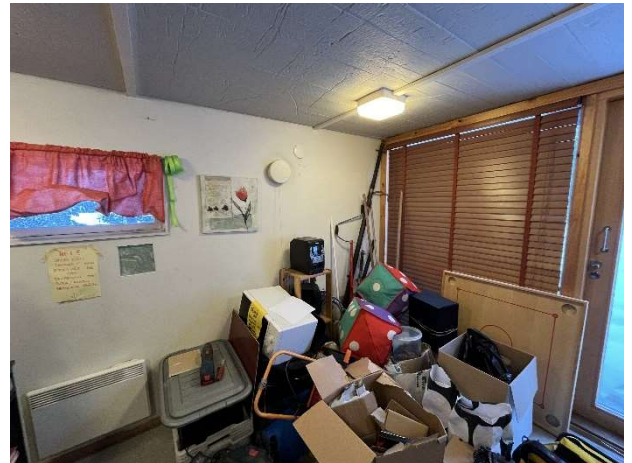
Kuva 77. Toimistotilan ulkoseinissä on sisäpuolinen lämmöneriste.
