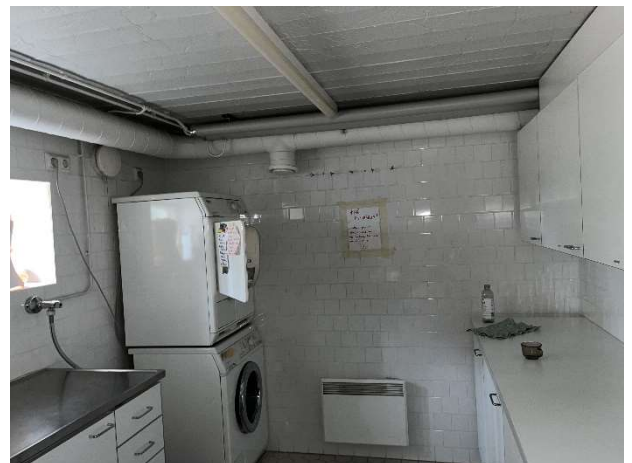
Kuva 79. Vaatehuollon tiloissa ulkoseinät ovat laattapintaisia.
