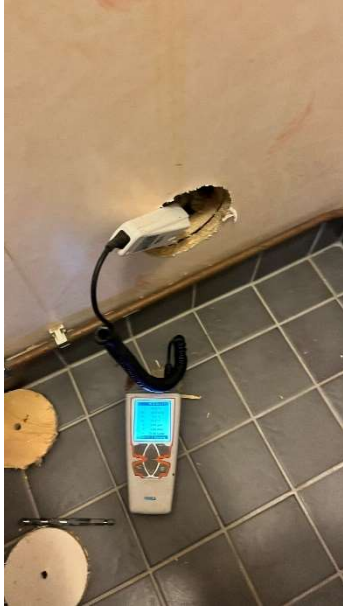
Kuva 170. Väliseinän rakenneavaus tehtiin WC-tilaan.
