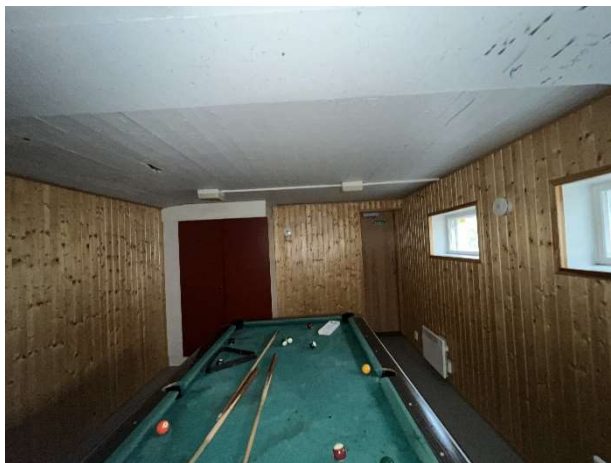
Kuva 78. Biljardihuoneen ulkoseinät ovat sisäpuolelta puupaneloituja.
