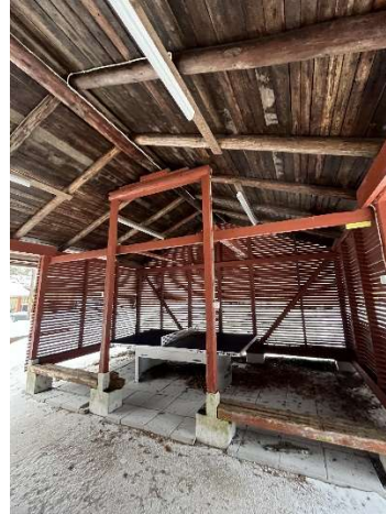
Kuva 116. Rakennuksen päädyssä on katettu tila.
