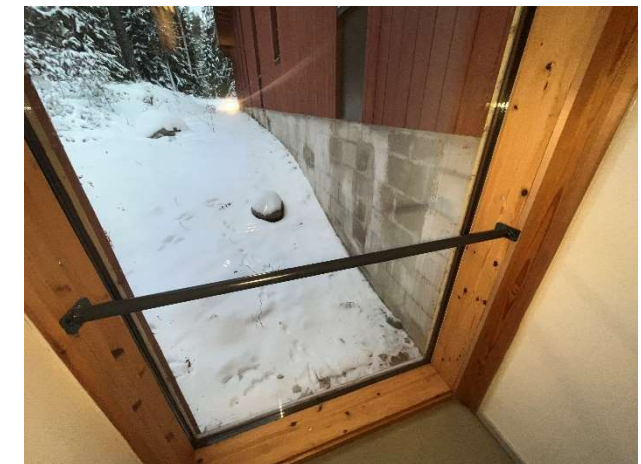
Kuva 22. Korkea ikkuna isos-osan käytävällä.
