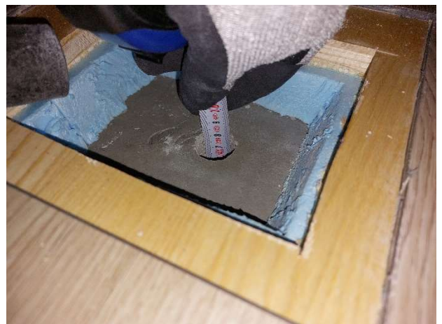
Kuva 120. Alapohjan rakenneavausta AP1.
