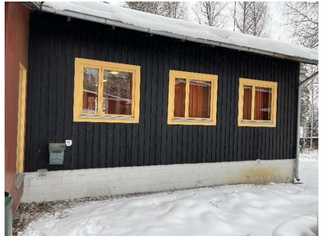
Kuva 54. Pohjoispuolen ulkoseinän vierusta on osittain kivetty luonnonkivillä.
