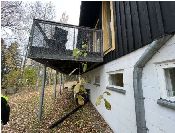
Kuva 51. Järven puoleista rakennuksen vierustaa.
