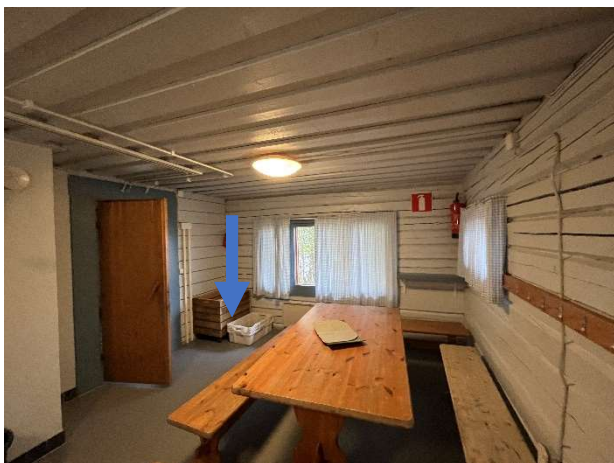
Kuva 156. Alapohjan rakenneavaus tehtiin tuvan nurkaan, nuolen osoittamaan kohtaan.
