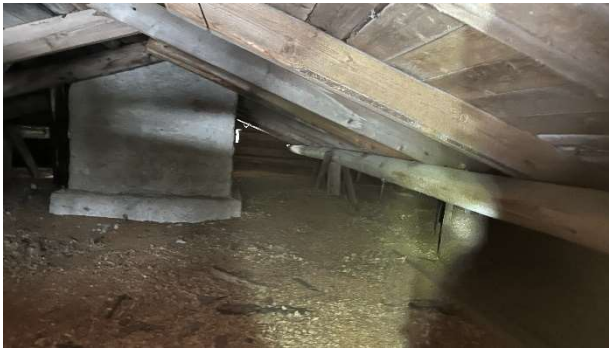
Kuva 176. Rakenneavaus YP1. Laipion pahvissa havaittiin selvää mikrobikasvua.
