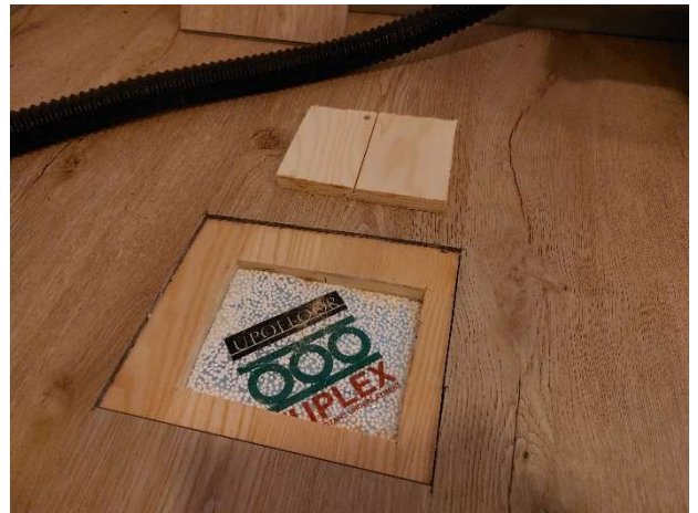
Kuva 118. Alapohjan rakenneavausta AP1.
