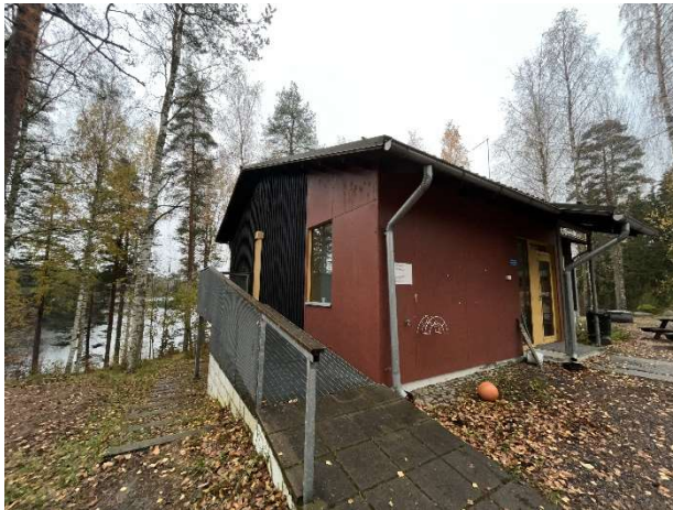
Kuva 72. Päärakennuksen eteinen ja WC-tilat on todennäköisesti rakennettu jälkikäteen.
