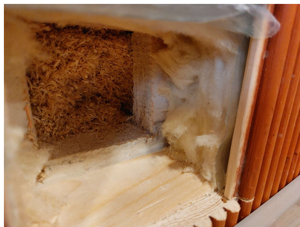
Kuva 92. Rakenneavaus US5, ruokasalin päätyseinä.
