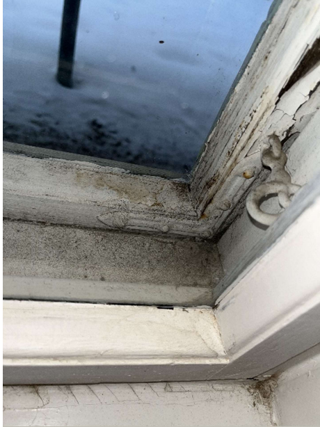
Kuva 88. Kellarikerroksen ikkunat ovat osin alkuperäiset.
