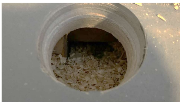
Kuva 158. Purueristettä on hyvin paksu kerros.
