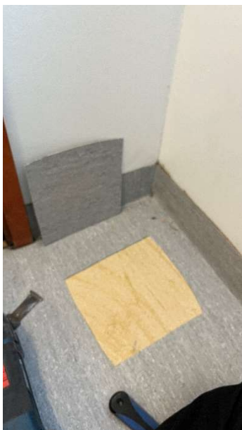
Kuva 63. Ensimmäisen kerroksen eteistilan lattia-avaus
