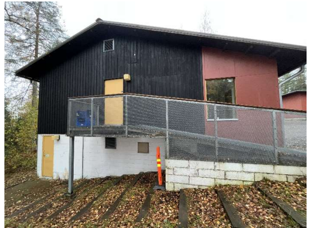
Kuva 48. Piha-aluetta ja rakennuksen vierustaa.
