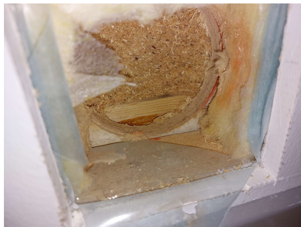
Kuva 90. Rakenneavaus US4, ruokasali.
