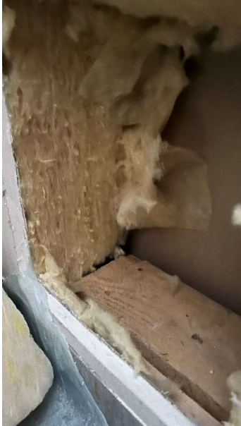
Kuva 23. Ulkoseinän rakenneavausta. Eristekerros on paksu.
