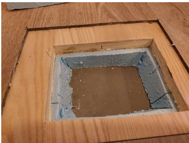
Kuva 119. Alapohjan rakenneavausta AP1. Parketin alla on finnfoam-eriste.
