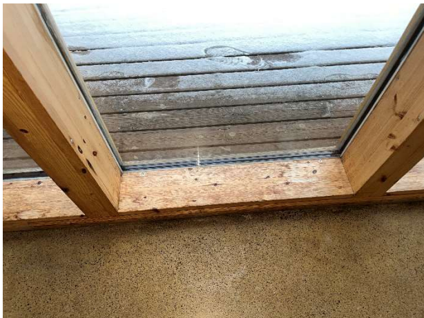
Kuva 27. Ikkunaseinien alapuolelle on jätetty karmin alle villakaistat.
