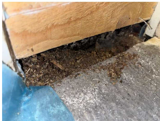
Kuva 85. Koolauksen alla vanhoja riveitä ja maatonutusta ainesta.
