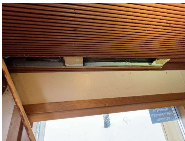
Kuva 148. Yläpohjan rakenneavausta (YP1).
