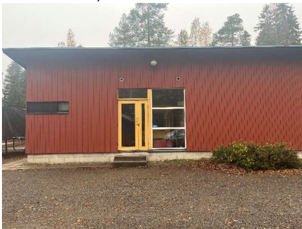
Kuva 21. Etupihan puolella sokkelin kevytbetoniharkot näkyvät selvästi.
