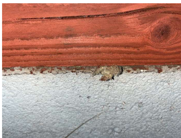
Kuva 169. Alimman hirren ja sokkelin välissä on arviolta villakaista.
