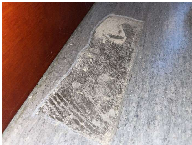
Kuva 12. Bulk-näytteenottoa muovimatosta.
