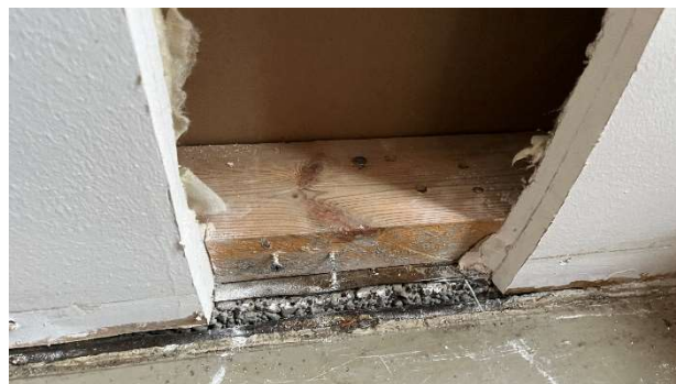
Kuva 16. Myös väliseinien alaohjauspuiden alla on bitumikermikaistat.
