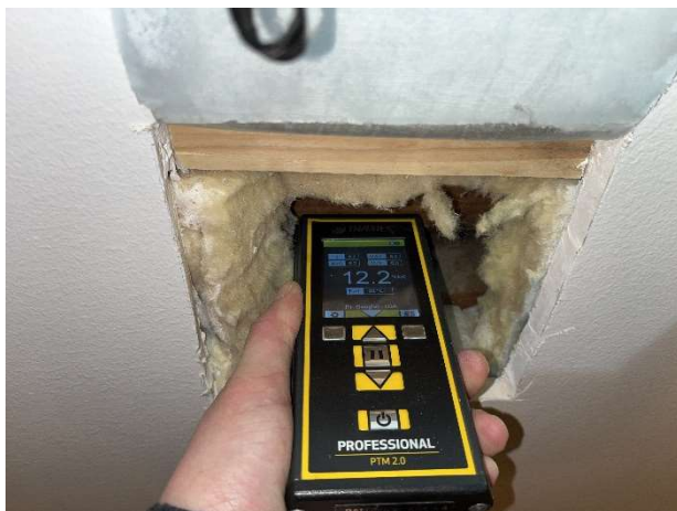
Kuva 137. Rakenneavaus US3. Poikkeavia puunkosteusarvoja ei havaittu.
