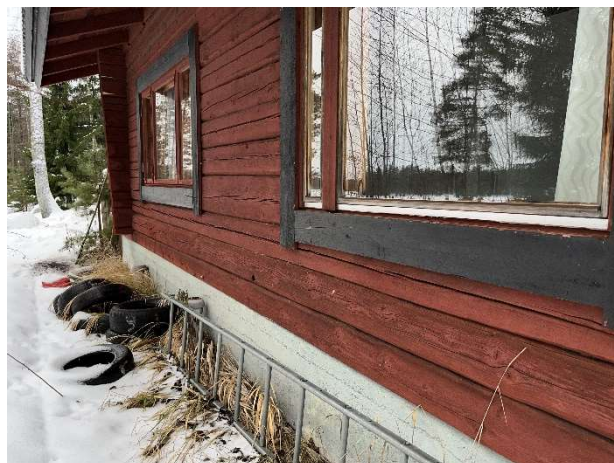
Kuva 167. Järven puoleista ulkoseinää.
