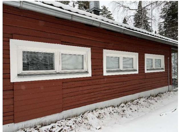
Kuva 124. Ulkoseinäarakenteteeseen on tehty muutos lautaverhoilun alueella.
