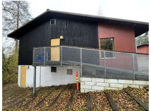
Kuva 106. Katto on mahdollisesti jatkettu rakennuksen laajennuksen yhteydessä.
