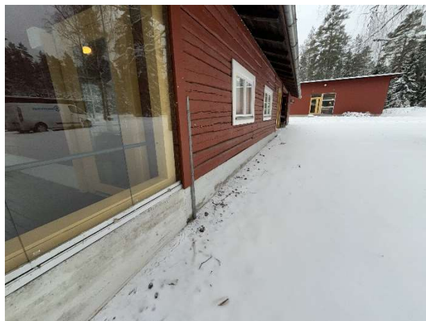
Kuva 128. Lasitetun terrassin ja ulkoseinän liittymää.
