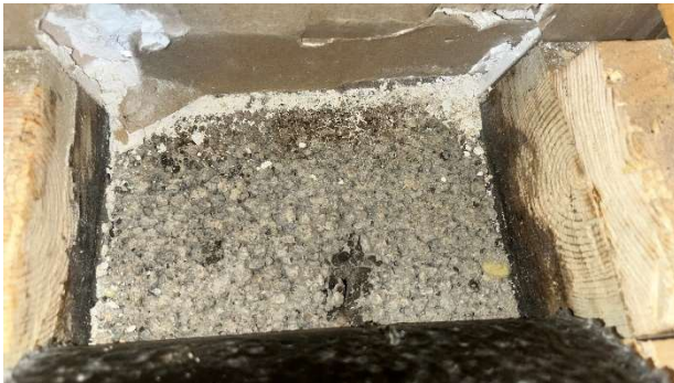
Kuva 23. Ulkoseinän rakenneavausta. Eristekerros on paksu.
