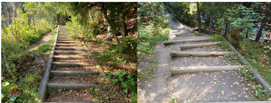
Kuva 15. Siippoontien eteläpuolisen osan tukkiportaikkoja.
