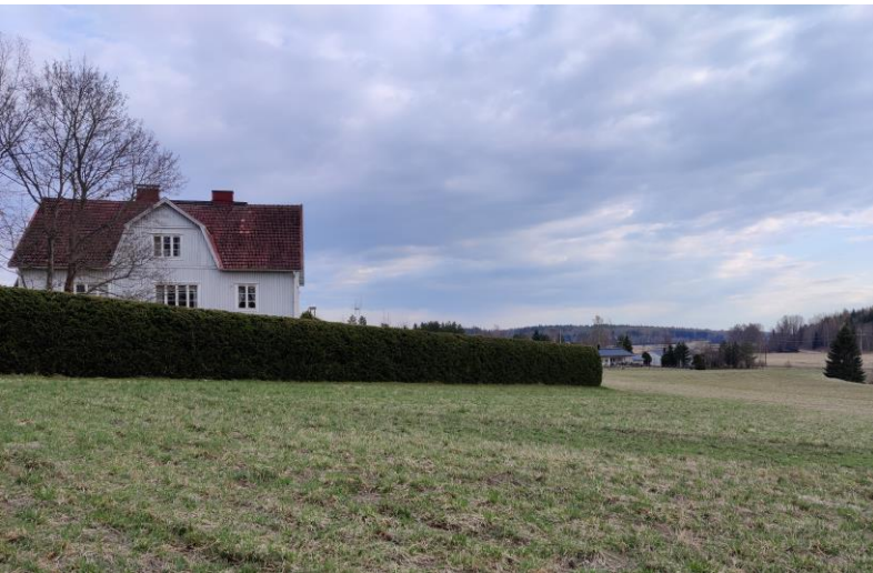
Reinikkalan alkutalon tilakeskuksen päärakennus ja pihaa reunustava komea kuusiaita on voimakas rajaava tekijä mutta siitä huolimatta viljelymaisemaan istuva. Taustalla näkyy uudemman rakennuskannan ja viljelymaiseman rajapinta jota ei ole rajattu.
