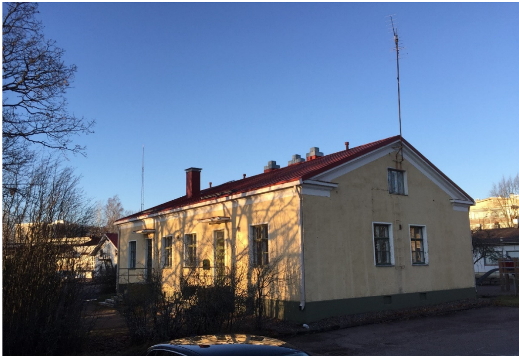
Kuva 6: Rakennus kuvattuna helmikuussa 2020.
