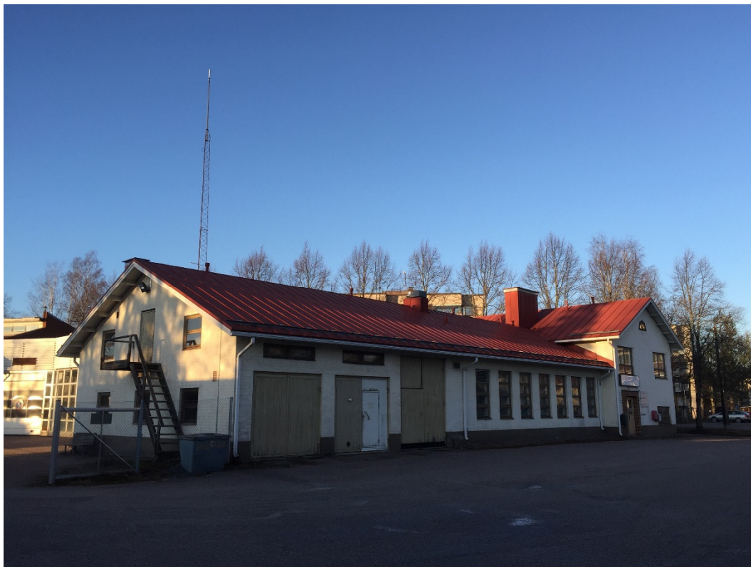
Kuva 12: Rakennus kuvattuna helmikuussa 2020.
