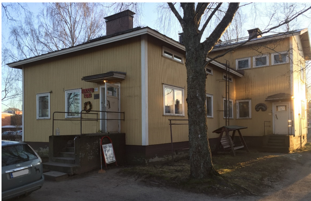
Kuva 9: Rakennus kuvattuna helmikuussa 2020.
