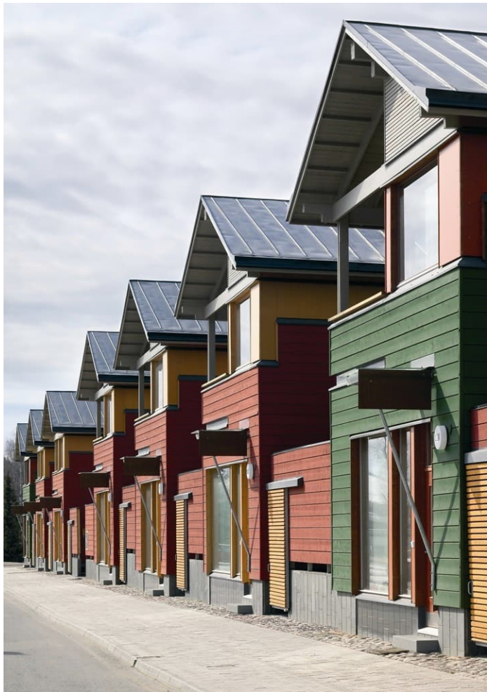
Porvoojoen länsirannalla sijaitsevien rakennusten maantasokerroksessa on rakennusoikeuden lisäksi sallittu toimisto- ja liiketilojen rakentaminen kadun varteen.
