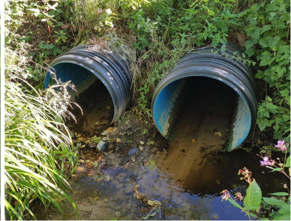
Kuvat 10. ja 11. Ylikorventien alittavat 800 mm muovirummut, oikeanpuoleinen kuva purkupäästä. [Ramboll 9/2021]
