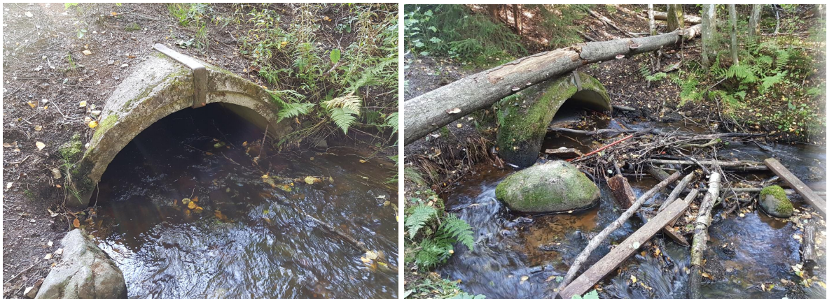
Kuvat 15. ja 16. Kassakummuntien alittava 1600 mm betonirumpuputki, oikeanpuoleinen kuva purkusuulta. [Ramboll 9/2021]
