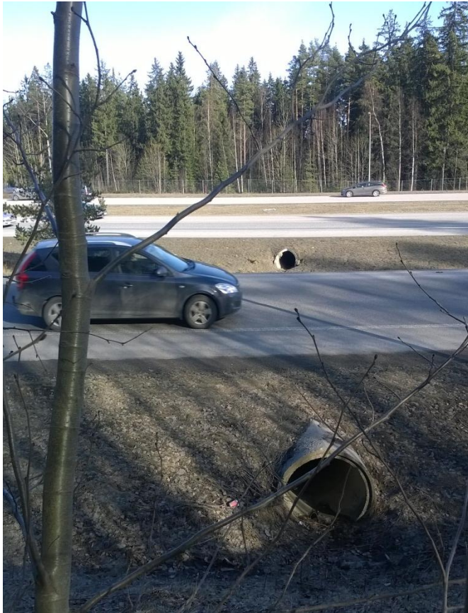
Kuva x. Korttelin 2405 pohjoisreunan kohdalla moottoritien allittavat rummut
