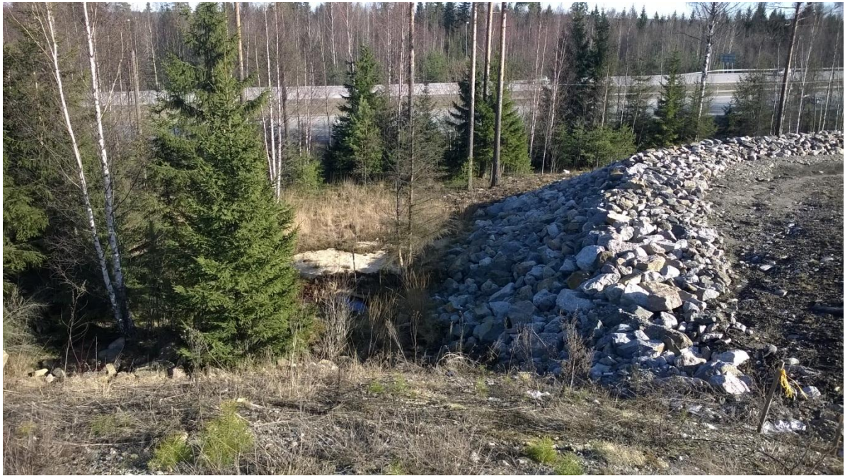
Kuva 11. EV-alueen eteläreunaa. Hulevesien laskuja sijoittuisi kiviluiskan alapuolelle
