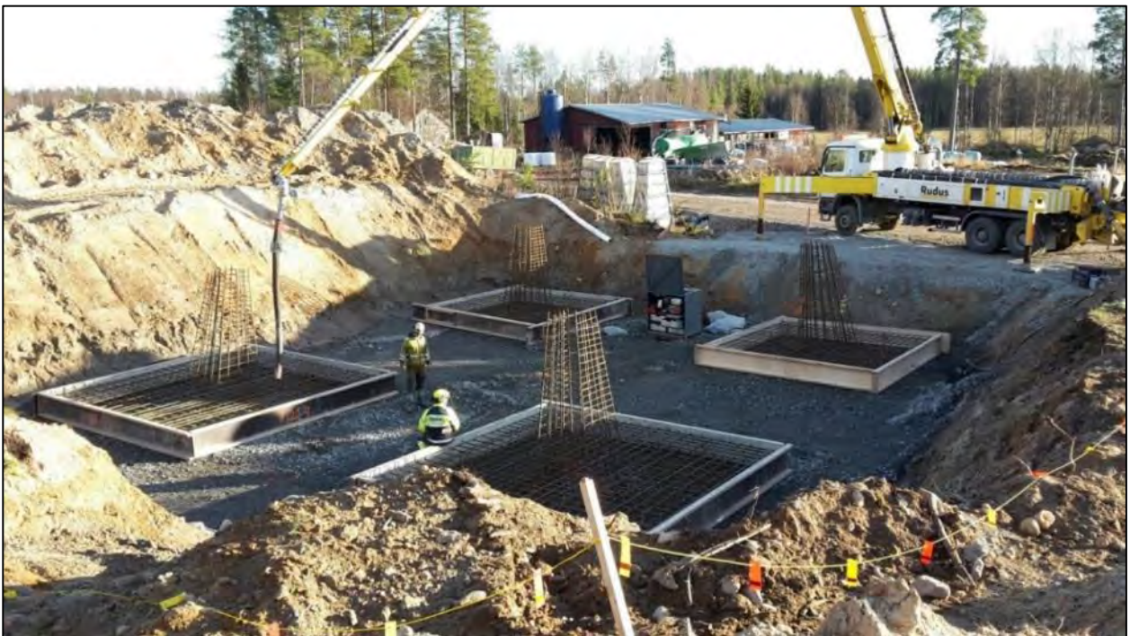
Kuva 3-5. Vapaasti seisovan pylvään perustuksen pohjatöitä.
