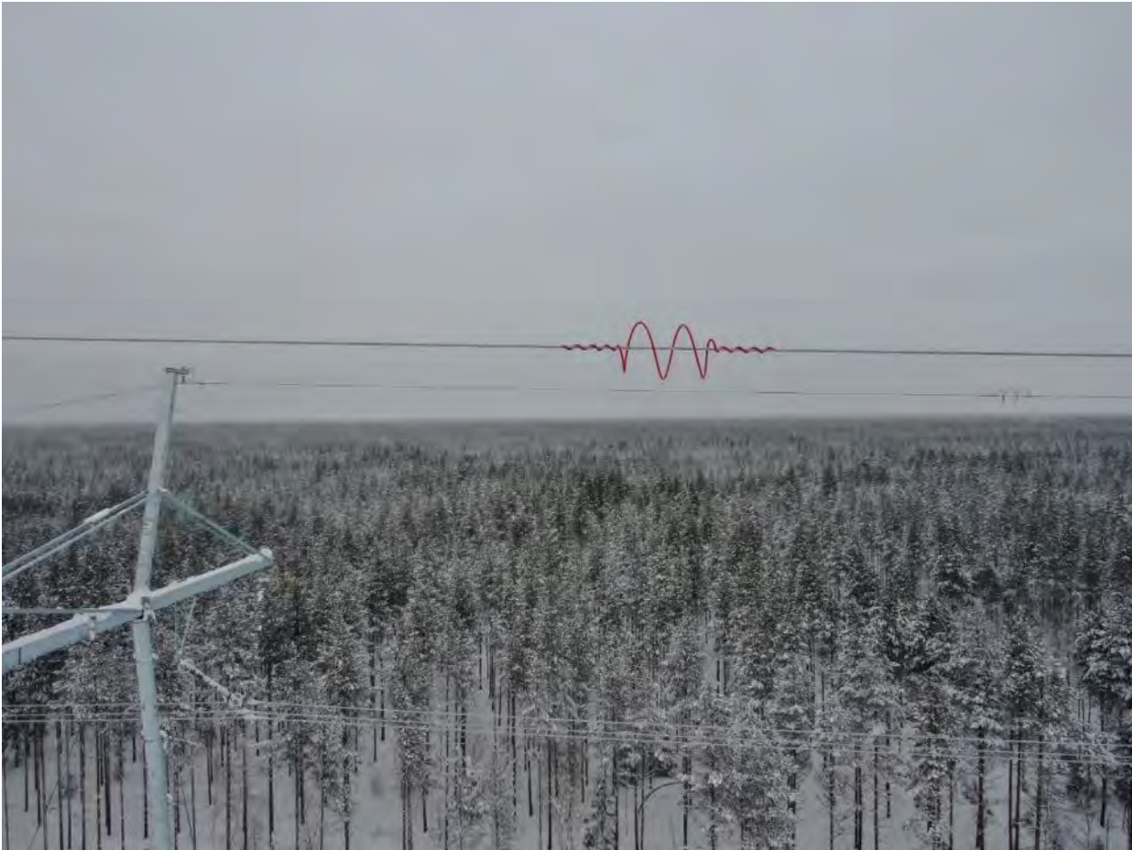
Kuva 6-5. Lintujen törmäysriskiä voidaan pienentää merkitsemällä ukkosjohtimet riskialttiissa kohdissa.
