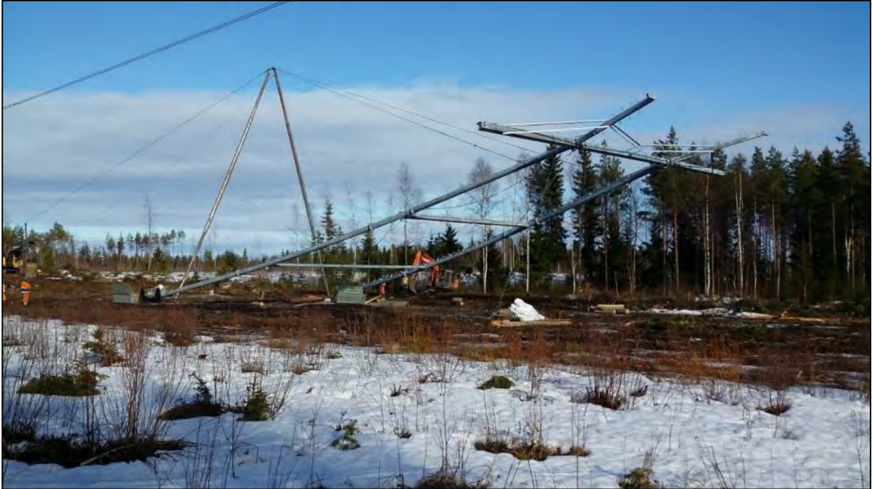
Kuva 3-7. Voimajohtopylvään pystytys.
