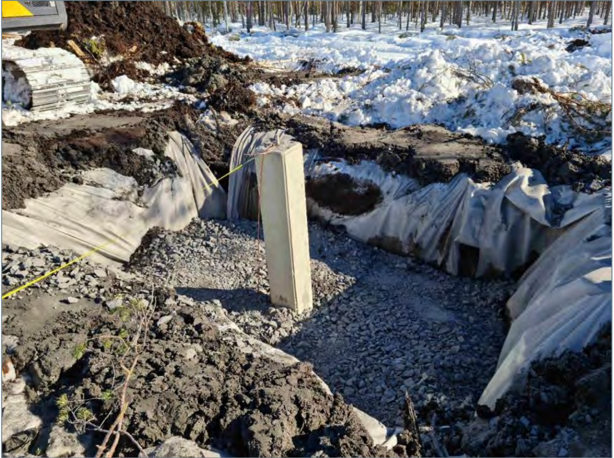
Kuva 3-4. Pylvään perustuselementin asentaminen.
