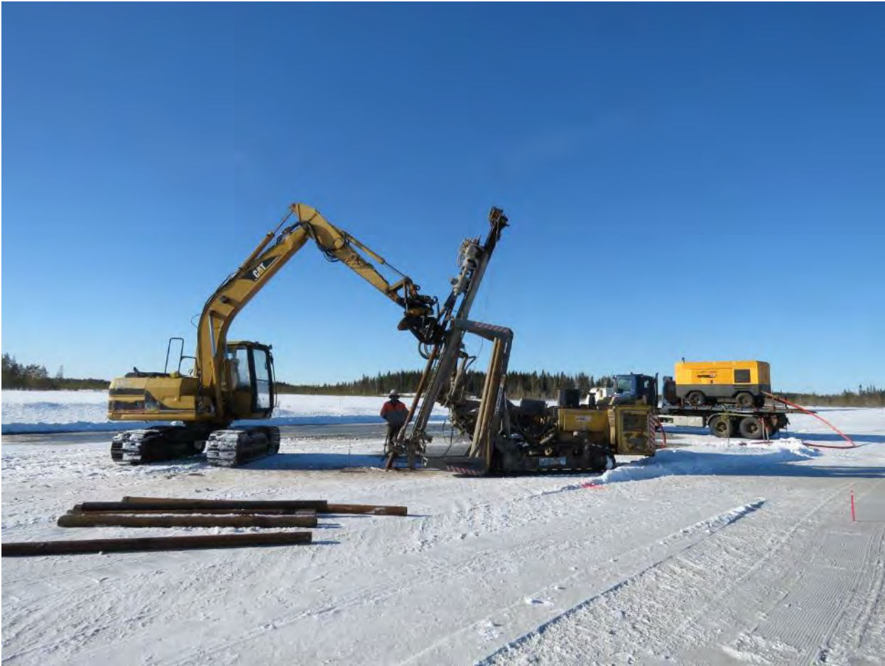
Kuva 3-6. Porapaaluperustuksen tekoa suoalueella, jossa työalue on jäädytetty.
