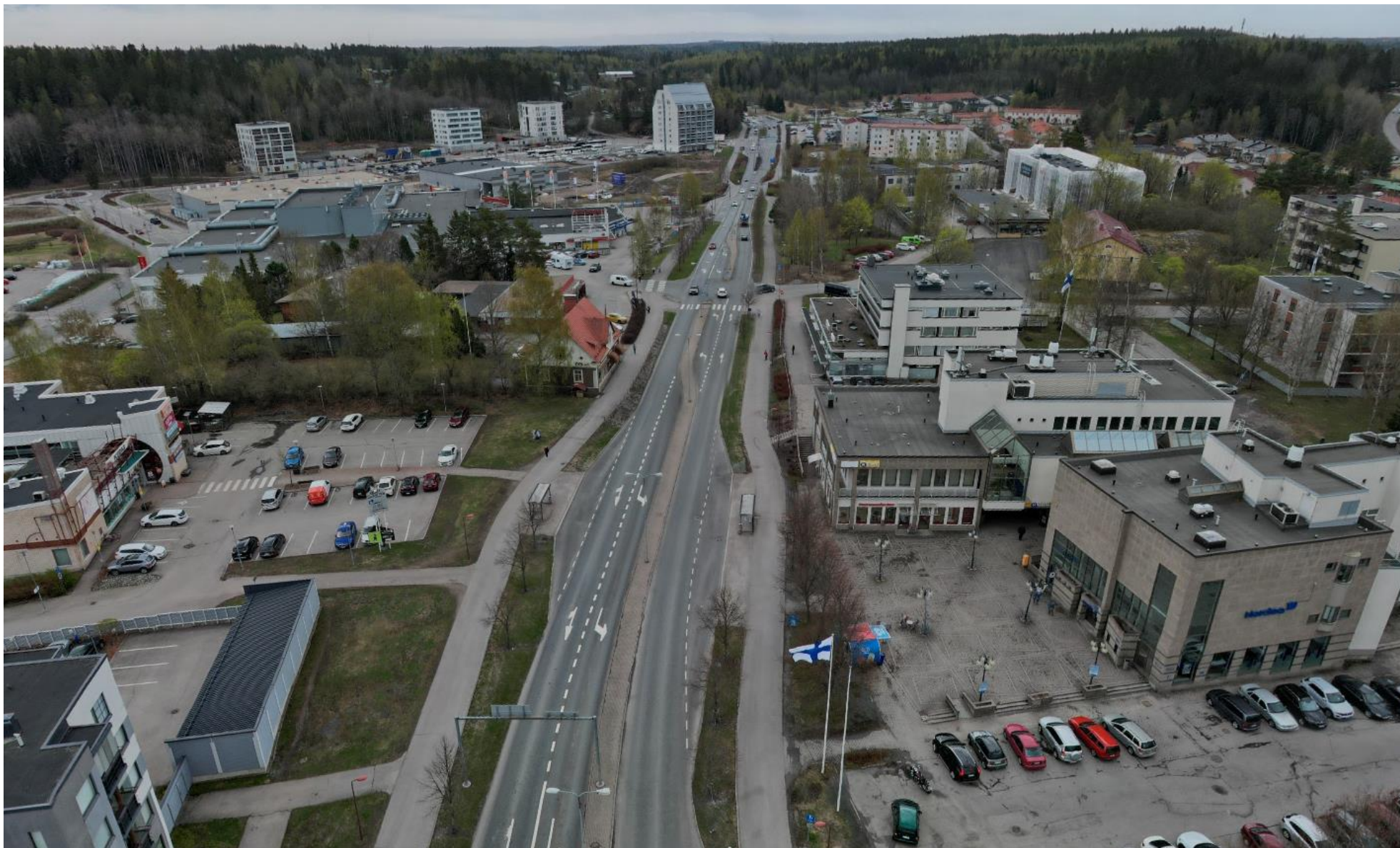
Klaukkalantie Klaukkalantien-Kuonomäentien liittymästä etelään
