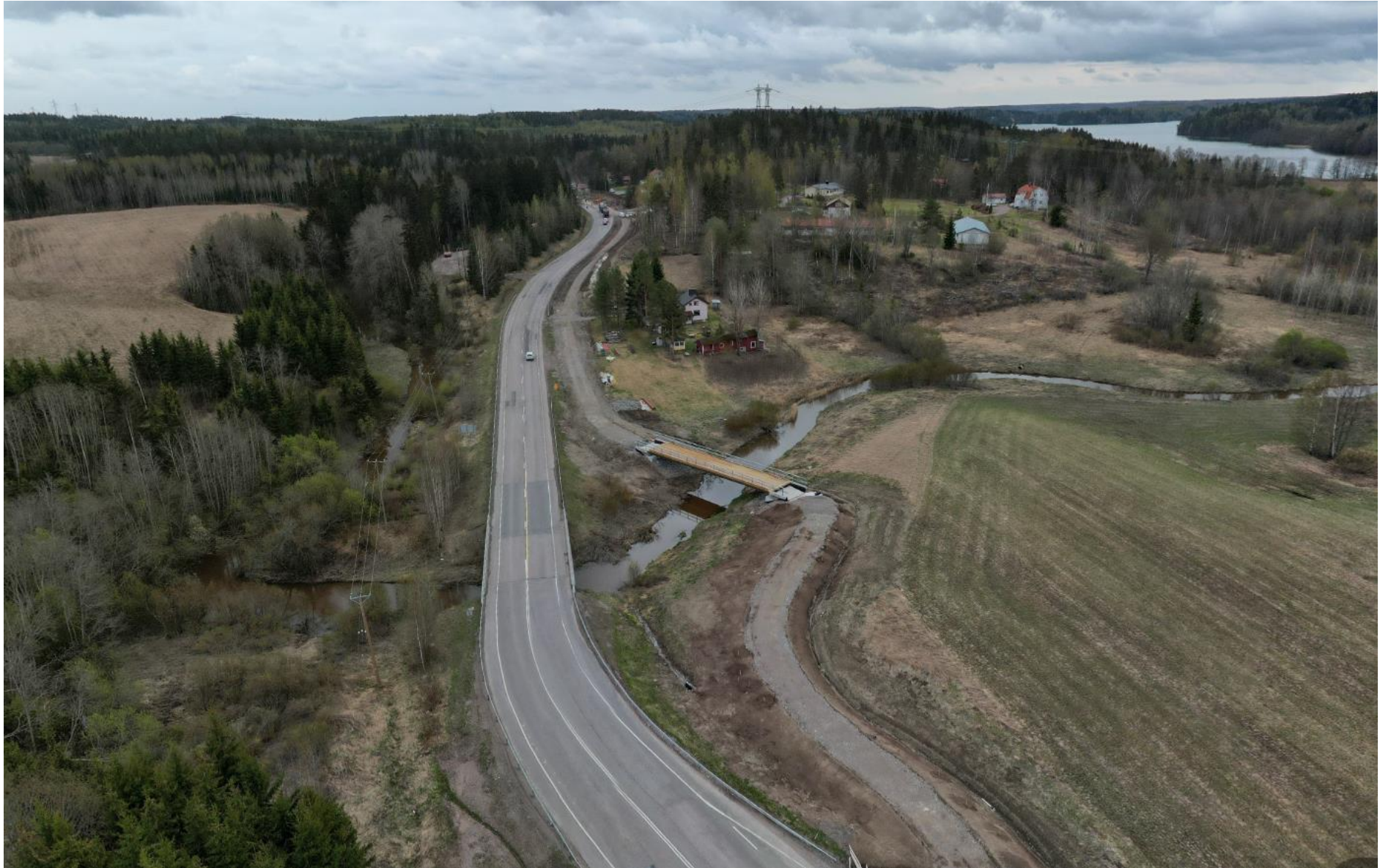
Klaukkalantie Luhtajoen kohdalta pohjoisosassa
