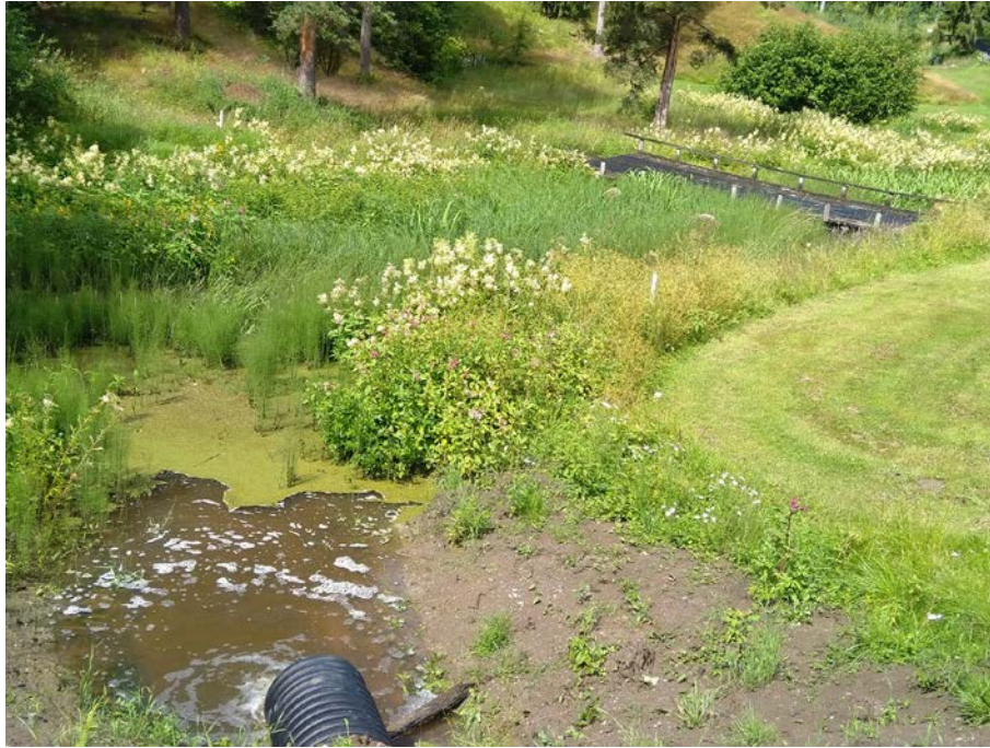
Kuva 3.29. Rinnekodin puhdistamon jätevedet Lakistonjokeen tuova purkuputki. Loppukesällä joen uoma oli kasvillisuuden valtaama.
