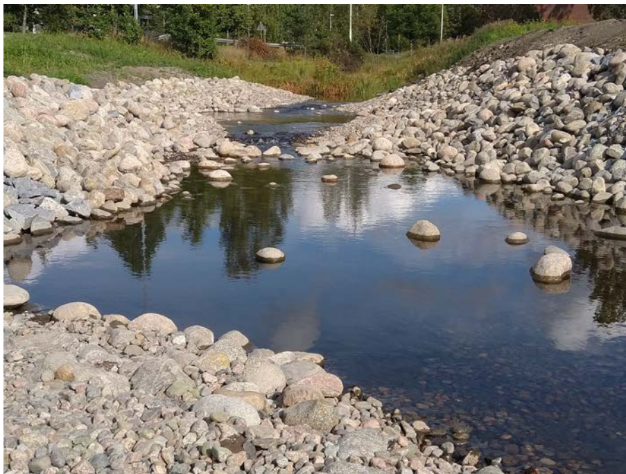
Kuva 4.2. Vantaanjokeen Riihimäellä rakennettu uusi tekokoski.
