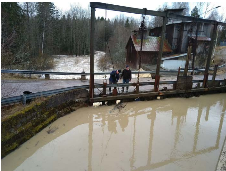
Kuva 3.46. Haarajoen patoaltaalla vesi nousi 17. helmikuuta 2020 nopeasti sateiden jälkeen. Tilannetta hankaloitti joen mukana tuomat puunrungot ja vene, joka tukkivat padon säätölaitteet.
