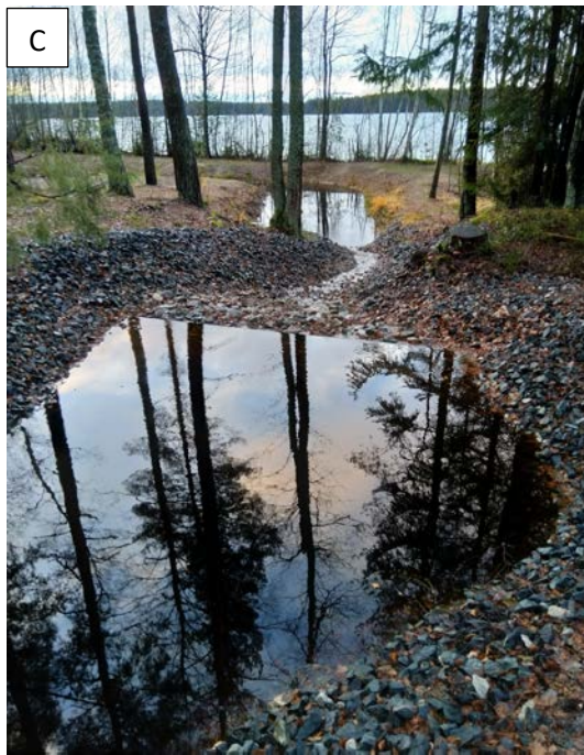
Kuva 3.1. Vihtilammin pato Sääksojan suuntaan ja sivuojan vedet tuova putki, b) Sääksojaan laskeva turvekankaan kuivatusoja, c) Sääksojan alajuoksun viivytysallas ja d) lisäveden purkukohta Sääksjärveen.
