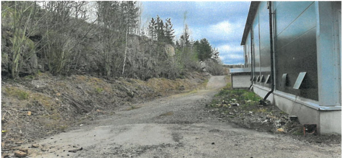
Kuva 4. Valokuva 5.5.2021 alueen eteläosasta pohjoiseen, vasemmalla louhittua kallioseinämää, Kekkilän halli oikealla.
