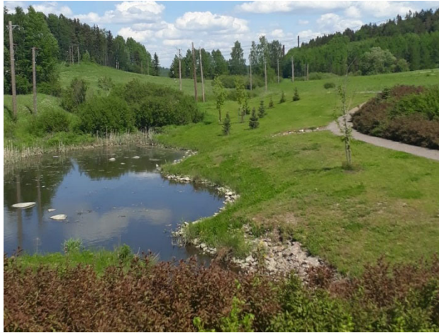
Kuva 6. Alueen pohjoispuolella on jo rakennettu hulevesien viivytysallas.
