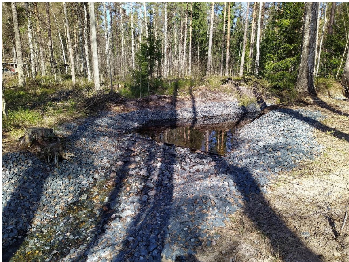
Kuva 3. Sääksojan alaosan pohjakynnyks. (FCG 14.4.2021)
