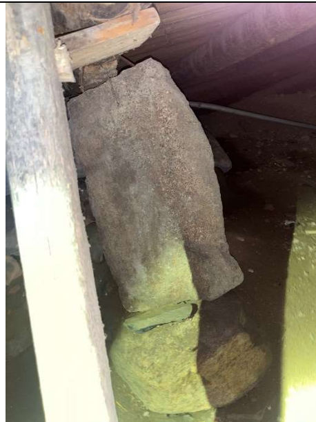
Kuva 7 Alapohjarakenteiden tuentaa
