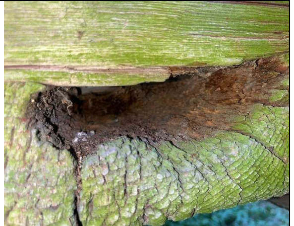
Kuva 37 Lattialankuissa lahovaurioita.
