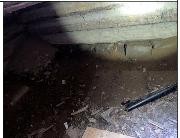
Kuva 6 Ryömintätilaa ja ulkoseinän alaosan hirsirunkoa.
