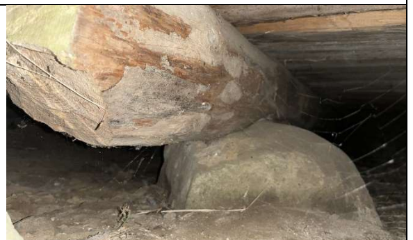
Kuva 18 Alapohjaa ja ryömintätilaa.
