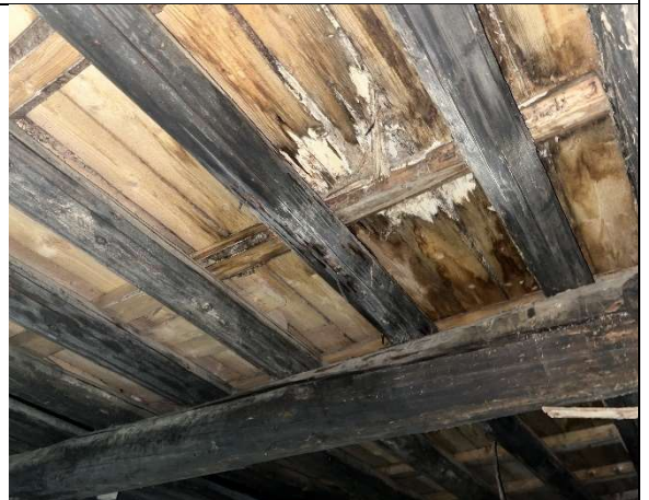
Kuva 48 Välipohjan lahovaurioita.
