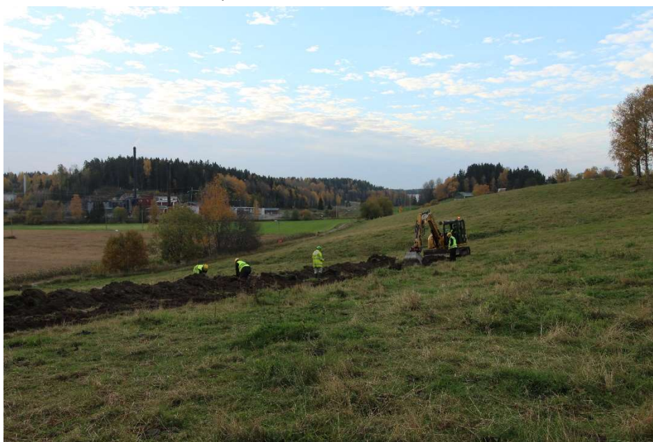
AKDG6964:5. Yli-Kunnari. Työkuva. Koeojaa 1 kaivetaan. Kuvattu Luoteesta. Kuvaaja Tuija Väisänen.
