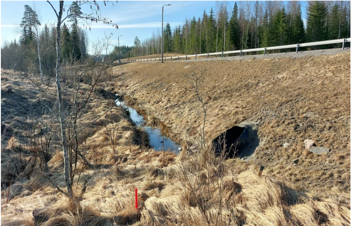
Kuva 5. Klaukkalan kehätien alittava 1600 mm rumpu. 800 mm betonirumpu jää kuvassa oikealle ja on teräsrumpua huomattavasti korkeammalla. (Ramboll 4/2025)
