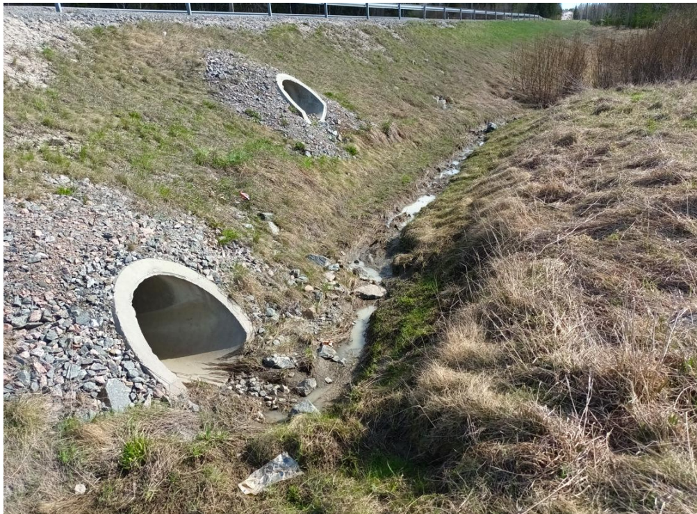
Kuva 13. Klaukkalan kehätien alittavat rummut kehätien länsipuolella. [Ramboll 5/2024]
