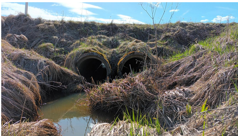
Kuva 13. Aittakalliontien alittavat 600 mm betonirummut suunnittelualueen pohjoisosassa. [Ramboll 5/2024]
