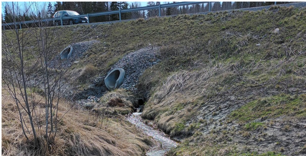
Kuva 14. Klaukkalan kehätien alittavat rummut kehätien itäpuolella. [Ramboll 5/2024]
