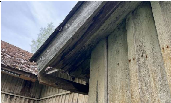
Kuva 15 Lahonneita räystäsrakenteita.
