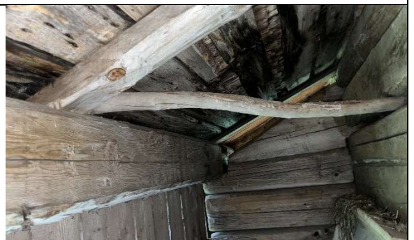
Kuva 30 Ulkoseinähirsien lahovaurioita.
