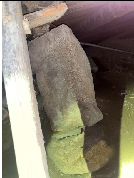
Kuva 7 Alapohjarakenteiden tuentaa
