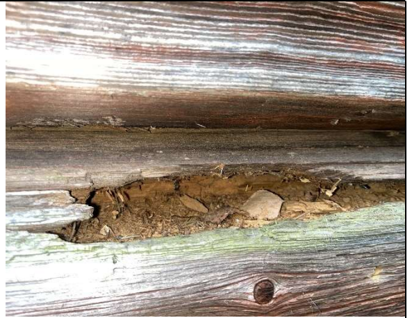
Kuva 35 Ulkoseinähirsissä lahovaurioita.
