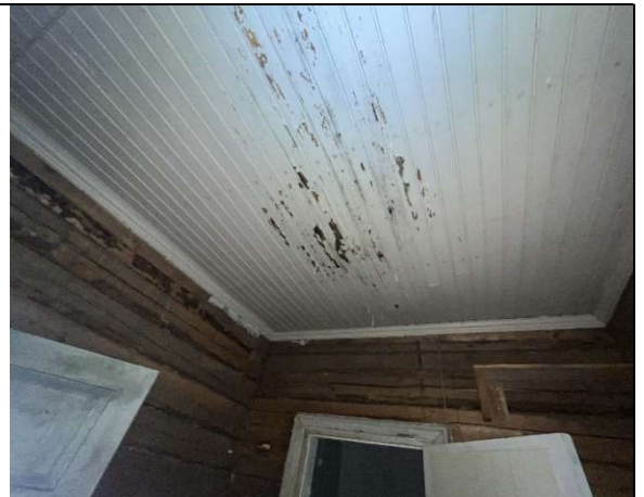
Kuva 4 Välipohja on notkolla.
