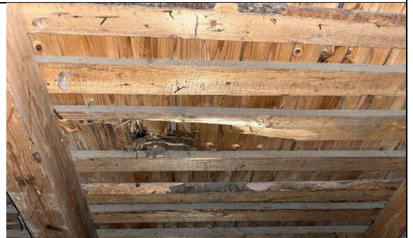
Kuva 16 Yläpohjan kosteusvaurioita.
