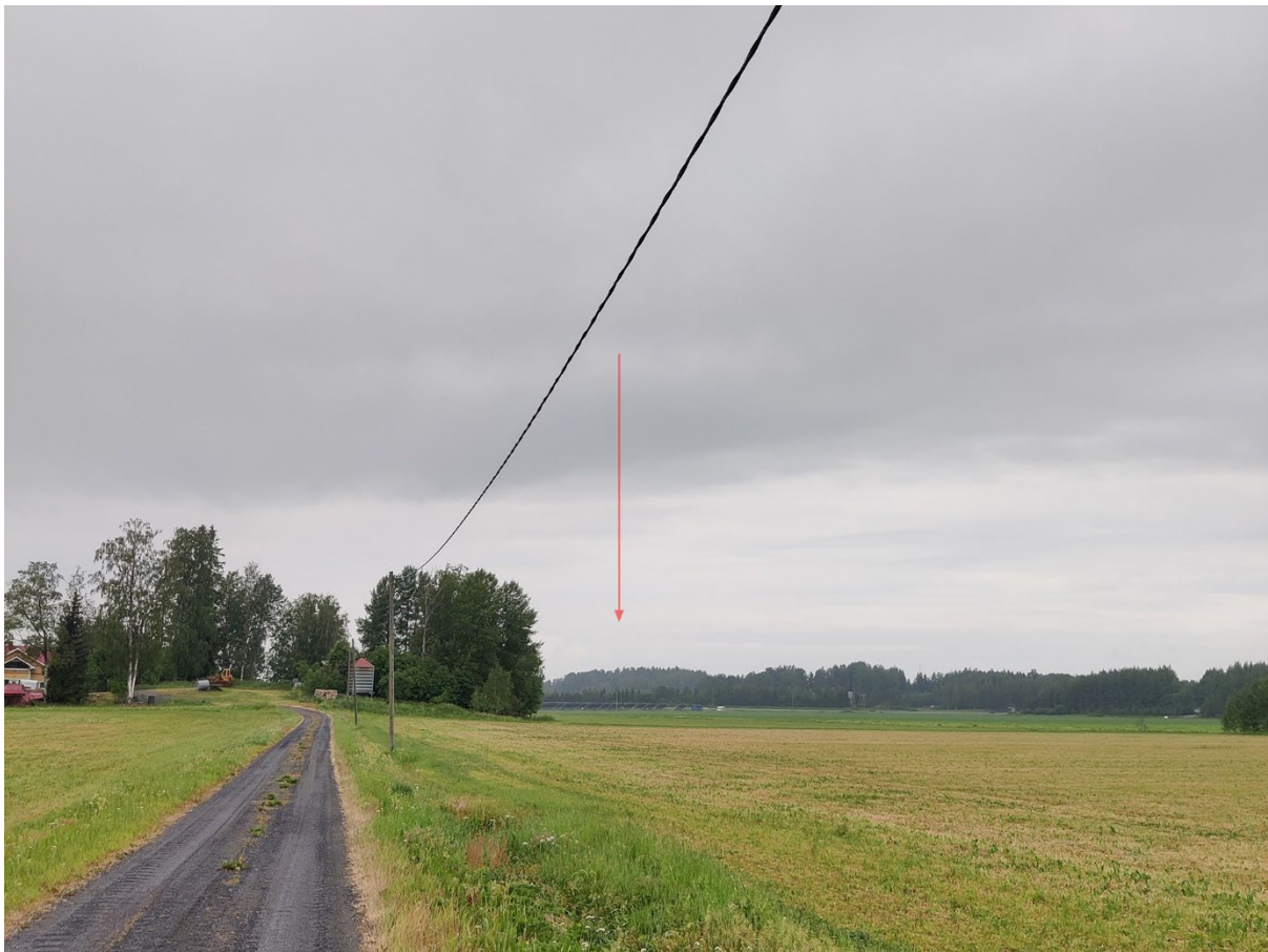
Kuva 22: Näkymä noin 600 metrin etäisyydeltä Helen Oy:n aurinkopaneelikentälle (Arkkitehtitoimisto Ajak Oy).
