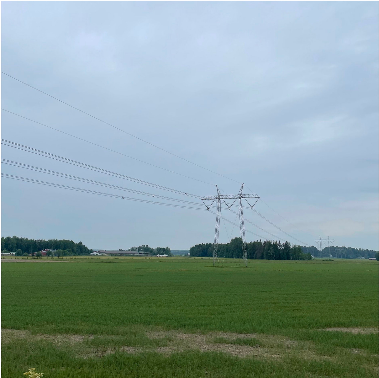
Kuva 03: Hankealueen läpi kulkeva 400 kV sähkölinja, Näkymä hankealueen länsiosasta kohti koillista (Arkkitehtitoimisto Ajak Oy).
