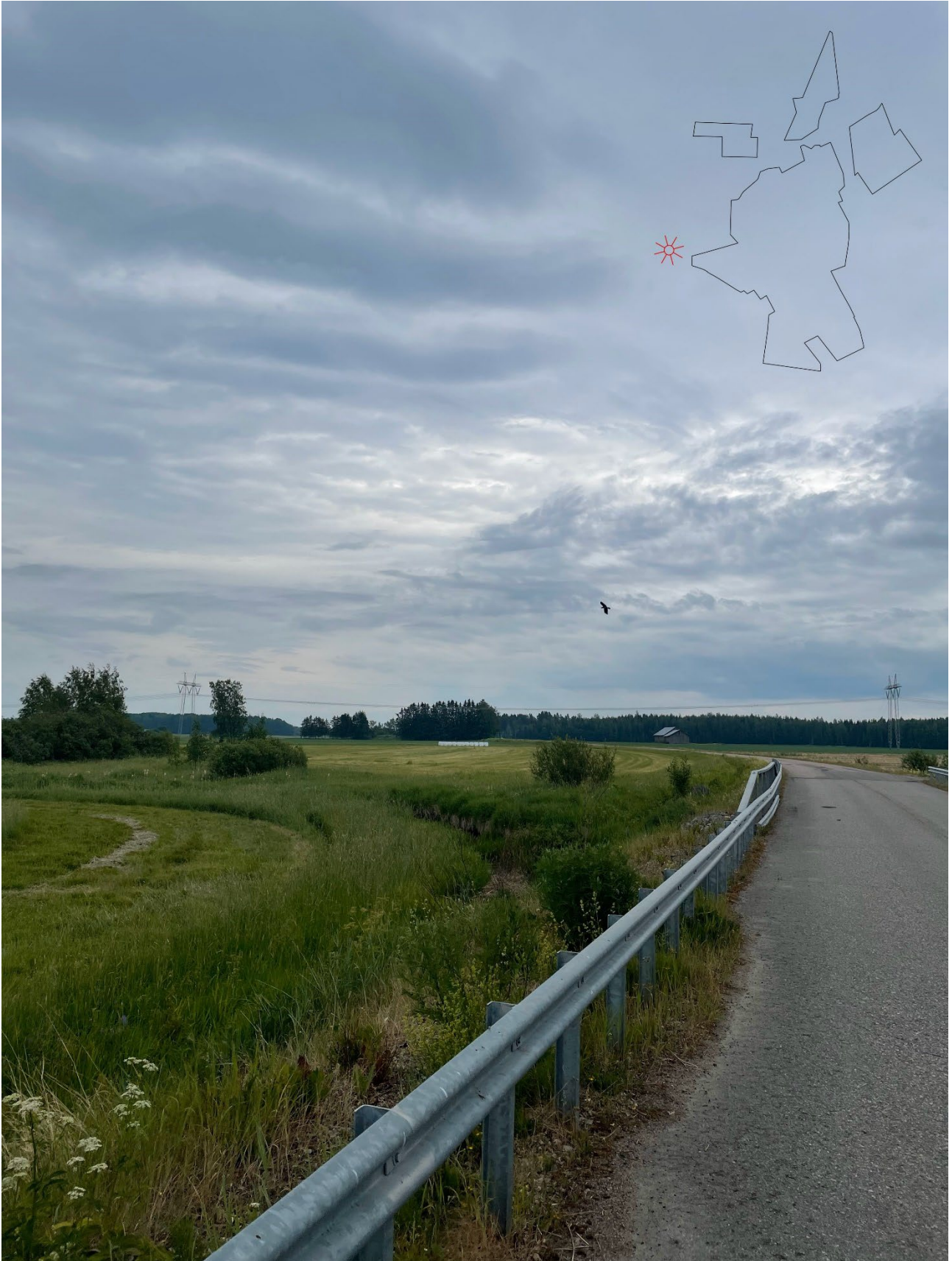
Kuva 20: Näkymä Koiransuolenojan siltarummun tasalta.
