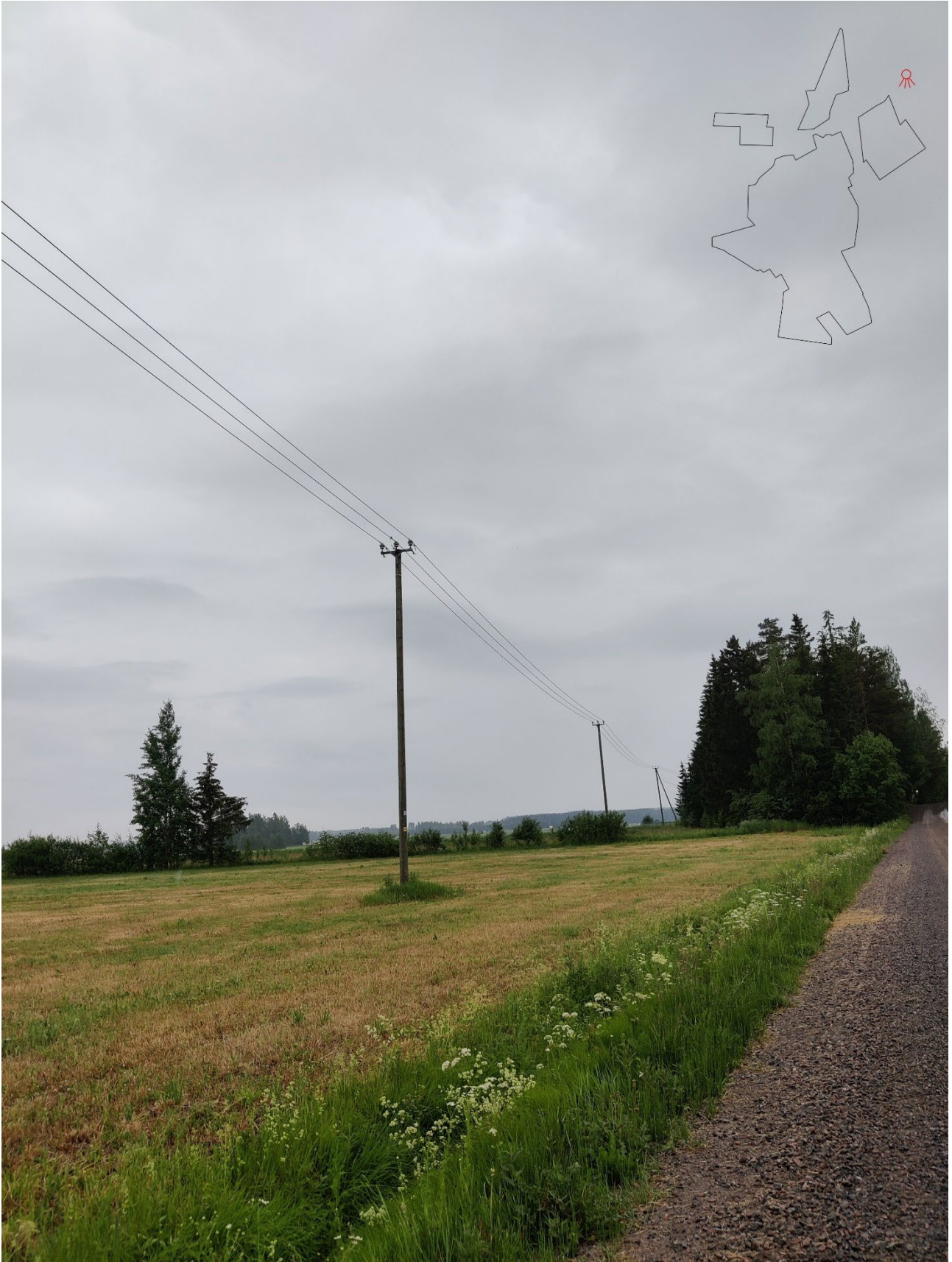
Kuva 27: Näkymä selvitysalueen koillispuolelta lounaaseen.
